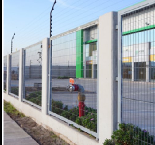
MURO PERIMETRAL CON CONTENCIÓN
